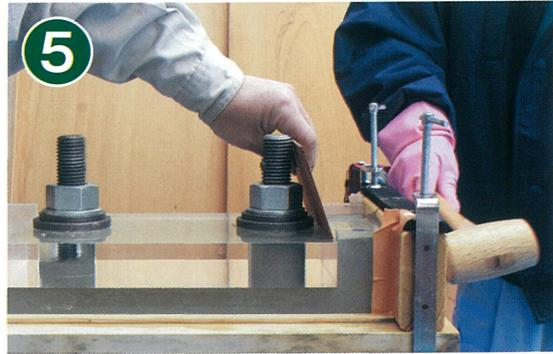
注入しながら打撃で流動化を促進させる。
