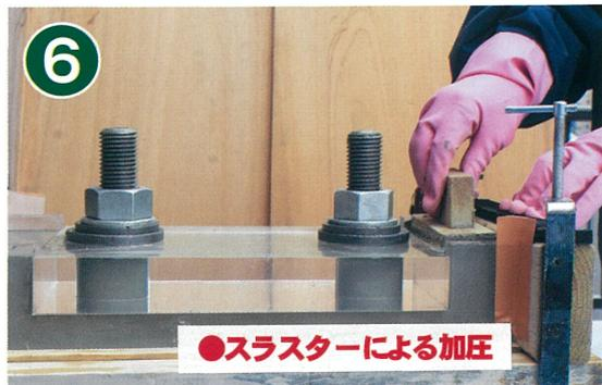
グラウト注入後、アンカーボルト付近を加圧しグラウト材をしっかりと充填させる。
