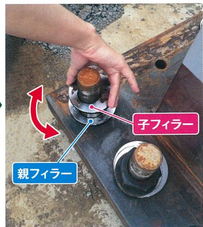
ベースプレートに所定のアンカーホールをあけておき、現場で親フィラー、子フィラーの順に落とし込むだけ。誰でもカンタンに設置可能!!
