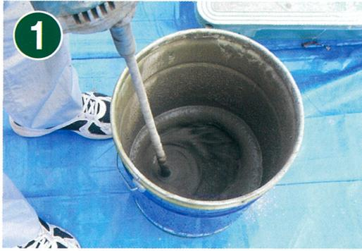
練混ぜ水にQグラウトを投入し、ハンドミキサーで2分±10秒を目安に練り混ぜる。
